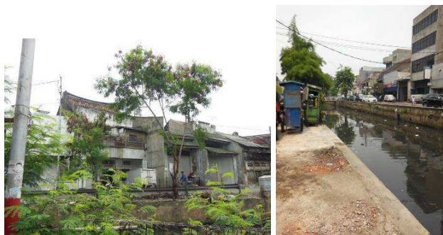
Gambar 5. Bangunan Tua yang Terlantar (kanan). Kondisi Sungai (kiri) Sumber: Dokumentasi Pribadi, 2015
