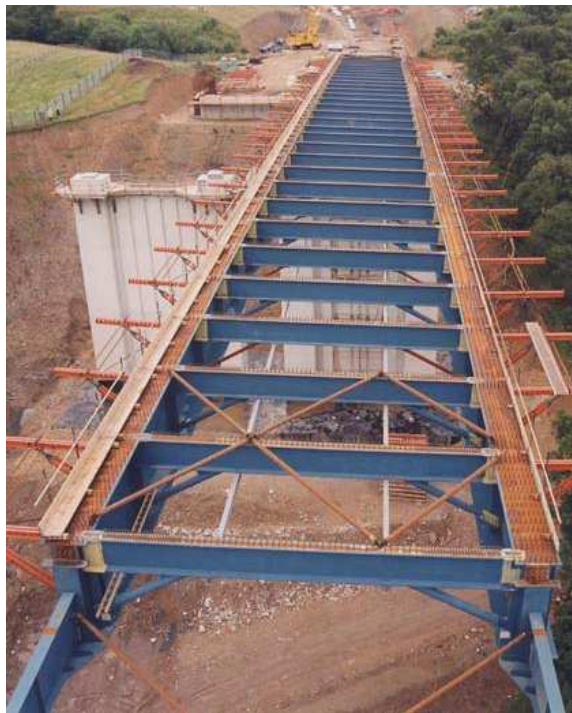
Gambar 2.8 Konfigurasi girder yang membentuk tangga pada ladder deck bridge .
