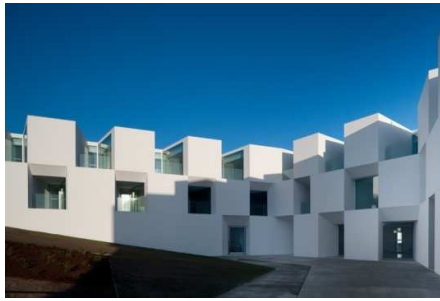
Gambar 22. Bangunan Residências assistidas em Alcácer do Sal Sumber: dezeen.com (Diakses pada tanggal 21 Maret 2015)
